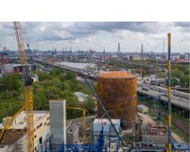
**Herzstück des Energiepark Hafen:** eine hocheffiziente **Gas- und Dampfturbinen (GuD)-Anlage** - ausgelegt auf synthetisches Gas.
