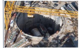
**Fernwärmehafen** unter der Elbe soll die **klimaneutrale Wärme aus dem Energiepark Hafen mit bestehendem Fernwärmenetz im Westen** Hamburg verbinden (Länge ca. 3 km).
