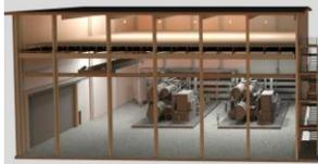
**Nutzung der Wärme des Abwassers mittels 60 MW Abwasser-Großwärmepumpe** auf dem Klärwerksgelände von Hamburg Wasser zur Versorgung von ca. **39.000 Wohneinheiten**.
